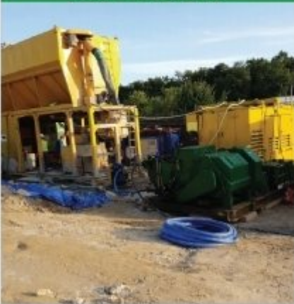
플랜트 조립 및 설치
